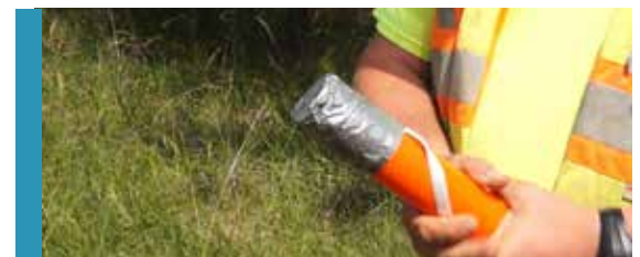
Asegure la tira de cinta al conducto
