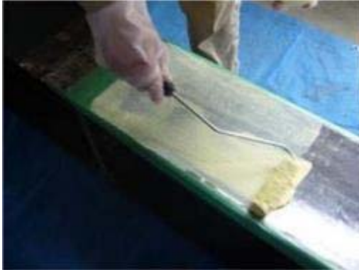
Applying primer using roller
